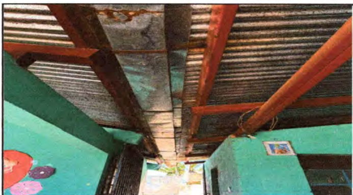
Foto 4: Mejoramiento de canal metalico y soporte (pescantes) debido a deterioro de los mismos.
