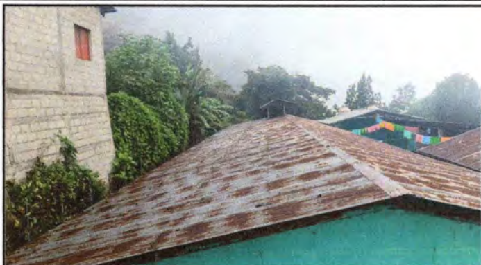
Foto 1: Sustrucción de lámina acanalada en mal estado por lámina troquelada aluzinc calibe 26 (areas de bodega, aulas y cocina).
