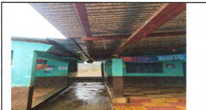
Foto 5: Mejoramiento de canal metalico y soporte (pescantes) debido a deterioro de los mismos.
