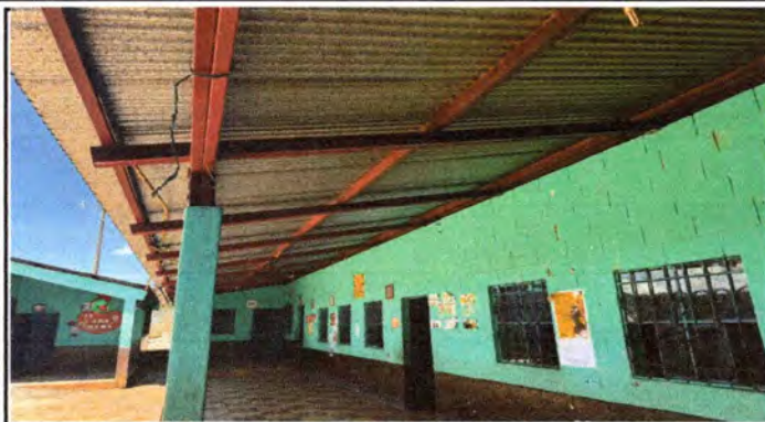
Foto 2: Instalación de lámina troquelada para mejorar las condiciones de los ambientes.
