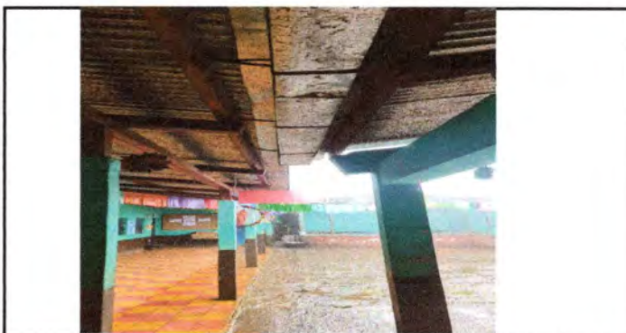
Foto 6: Mejoramiento de canal metalico y soporte (pescantes) debido a deterioro de los mismos.
